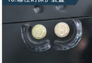
16. 螺栓的保护装置
